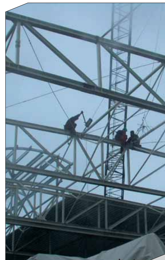
Ocelová konstrukce střechy kotelny Steel Structure of the Boiler House
