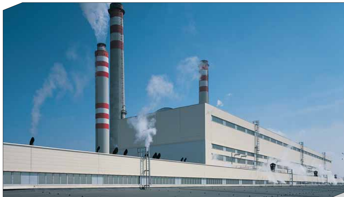
Celkový pohled Overview
