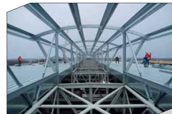
Ocelová konstrukce střechy kotelny Steel Structure of the Boiler House
