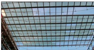
Obr. 4 – Konstrukce átria Palác Křižík (AHK architekti, Excon).
