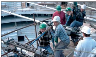
Obr. 8 – Sazka Arena, předpínání na volné délce.
