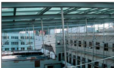
Obr. 5 – Palác Křižík – průhled konstrukcí
