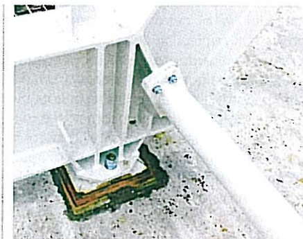
Uložení konstrukce na pevný kloub
