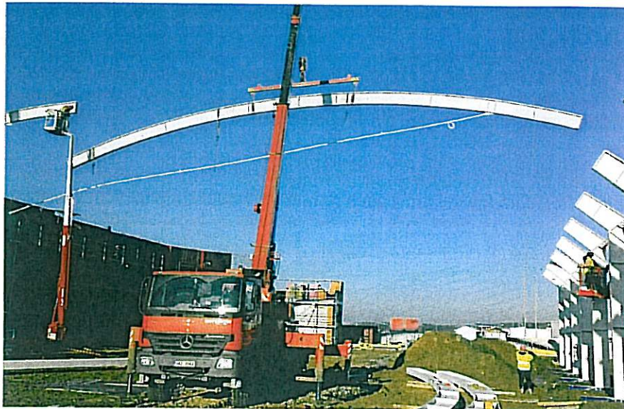
Zdvih obloukového vazníku
