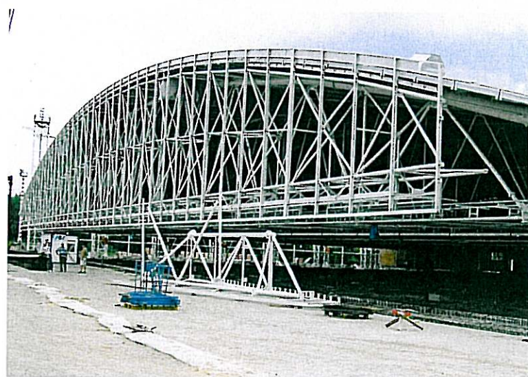
▲ Zvedání střešní konstrukce, stav 2 m
