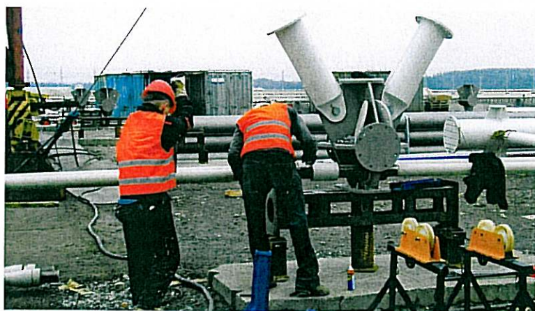
▲ Montáž táhel, styk táhel u styčnicku – spojka M105
