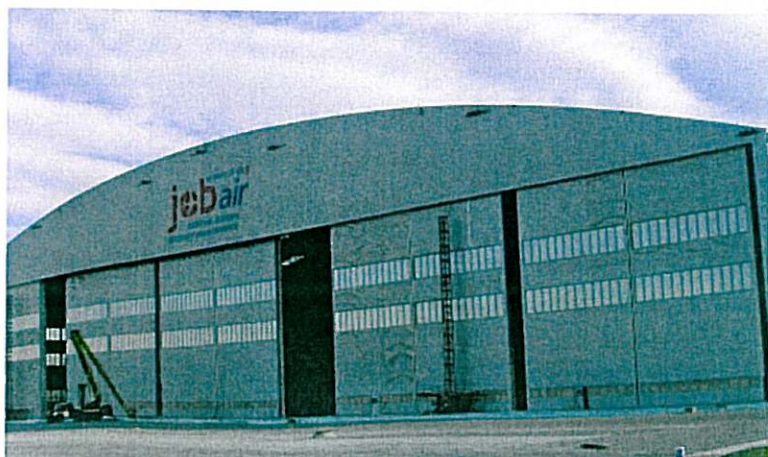
▼ Čelní pohled na stavbu hangáru po opláštění a montáži vrat
