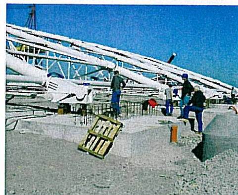
▲ Aktivace a předepnutí střešní konstrukce
