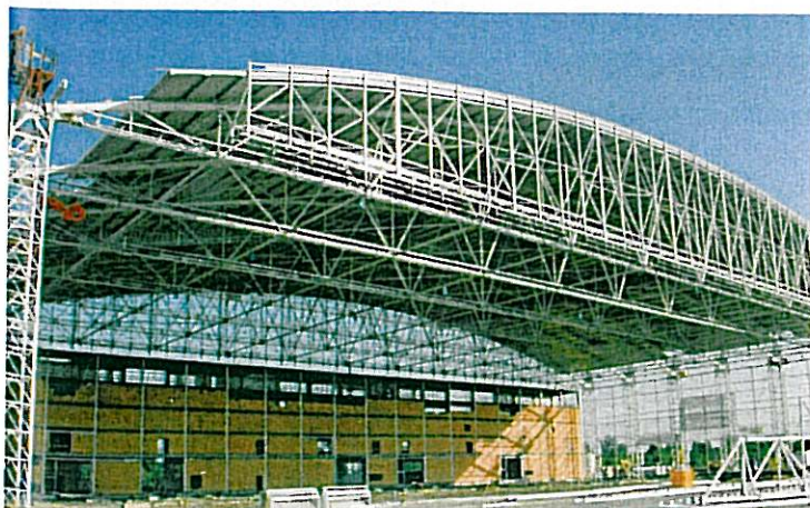
▼ Zvedání střešní konstrukce, stav 21 m
