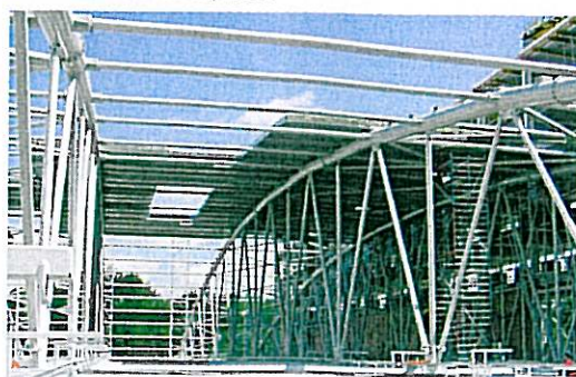
▼ Montáž střešního pláště
