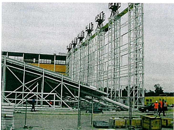
▲ Zvedání střešní konstrukce, stav 0 m
