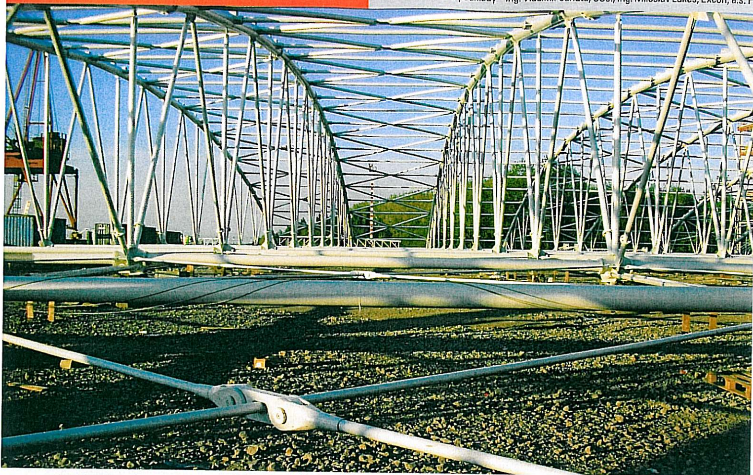
▲ Spodní vodorovné zavětrování – Macalloy M48, S460. Horní vodorovné zavětrování – TR Ø245, křížová spojka
