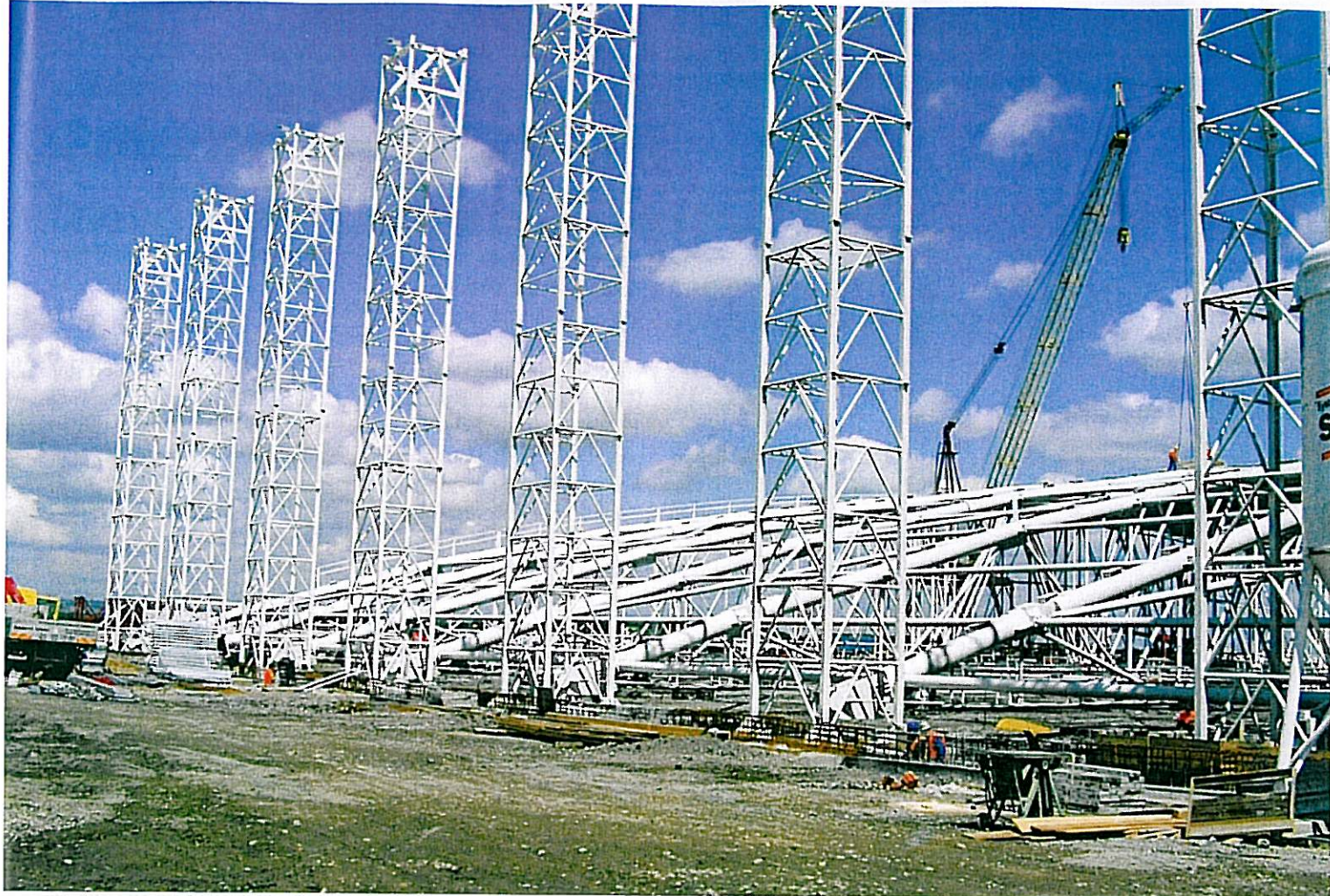
▲ Montáž sloupů a stěnových prvků
