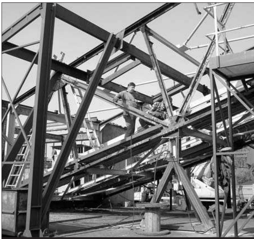
Nadzvedávání šikmého mostu při výměně diagonály
