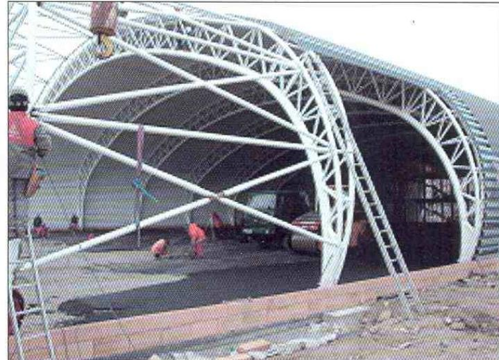
Na snímku pokládka spodního trapézu a aplikace asfaltového koberce uvnitř haly.
