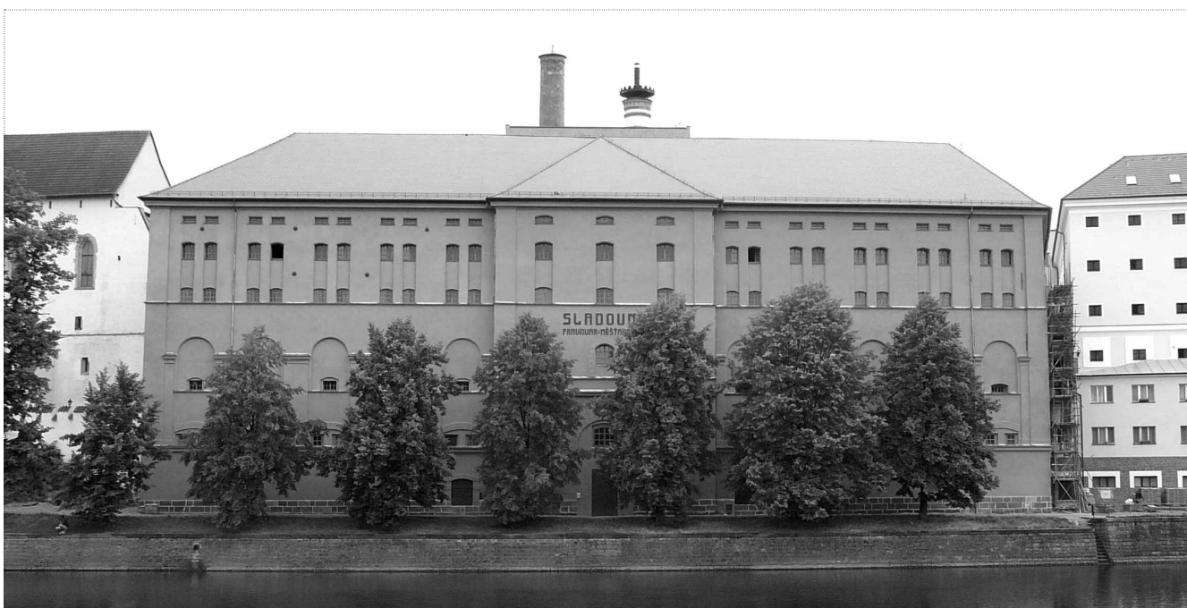
Pohled přes Otavu na opravenou fasádu
