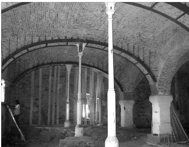
Podpěření kleneb dodatečnými litinovými sloupy
