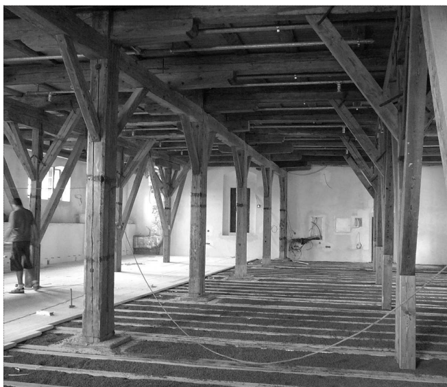
Nová podlaha stropu nad 2. NP s utopenými ocelovými nosníky
