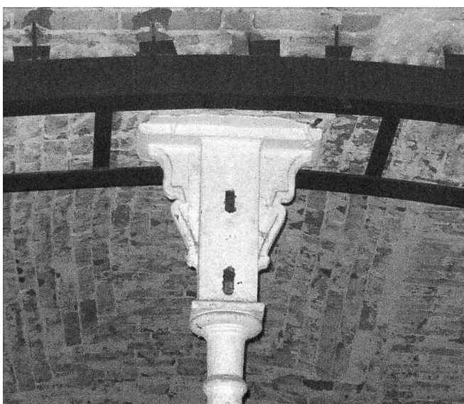
Detail litinové hlavice dodatečného sloupu (typová konstrukce přístřešků používaných např. na nádražích)
