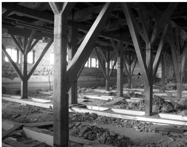
Sestavené nosníky po obalení a částečném zasypání
