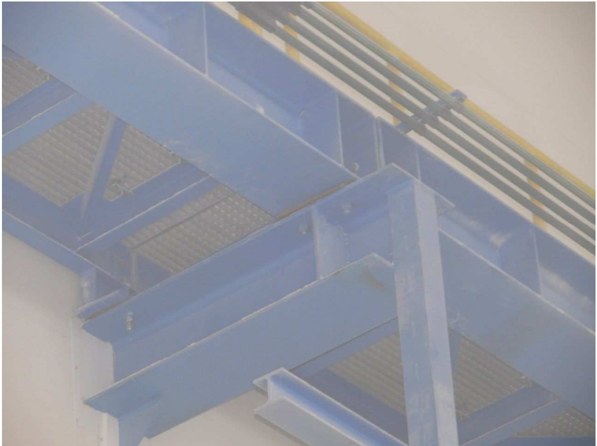
Obr. 5 Chybná rektifikace jeřábové dráhy
