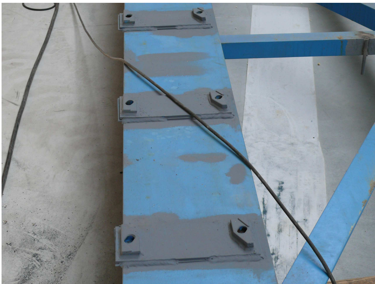
Obr. 7 Excentrické uložení kolejnice a „vertikální rektifikace“.
