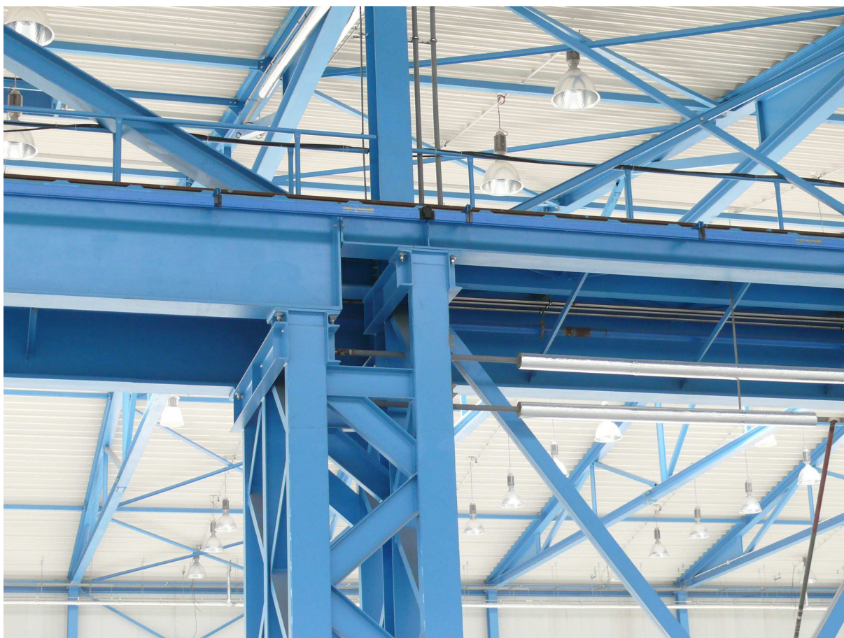
Obr. 6 Nevhodné řešení styku drah o různých rozpětích
