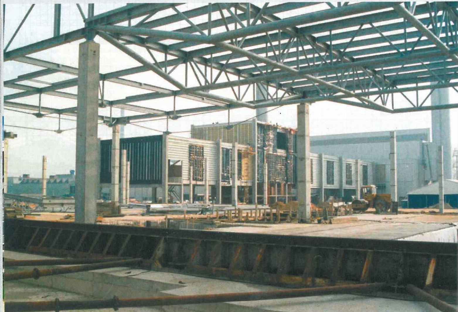
▼ Obr. 9. Přínradová konstrukce strojovny
