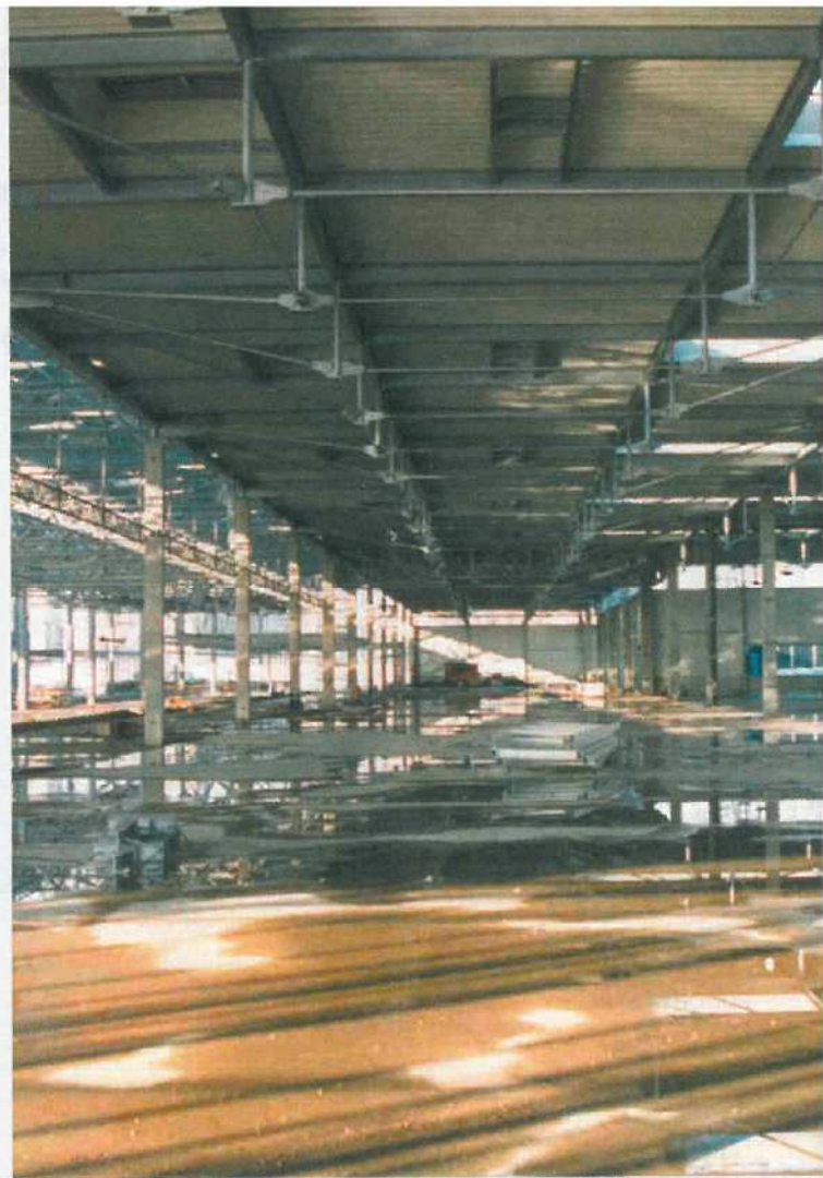
▲ Obr. 8. Fraktálové pole s prostorovými a rovinnými vzpínadly
