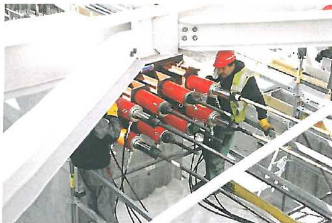
Ryc. 5. Walce do wysuwania rusztu nośnego pomostu
