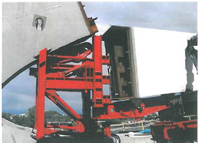
Ryc. 8a. Skrajna część łuku w pozycji transportowej
