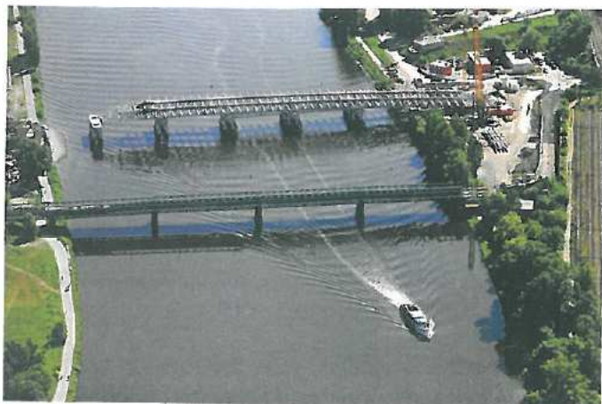
Ryc. 6. Widok wysuwanej konstrukcji z lotu ptaka
