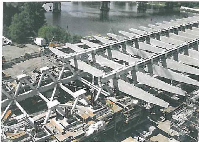
Ryc. 4. Stanowisko montażowe i część wysuniętego rusztu
