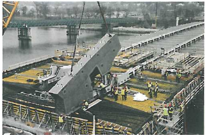
Ryc. 7. Osadzanie podstawy łuku
