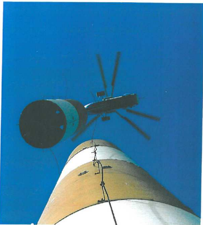
Obr. 1 – Výměna laminátového tubusu pomocí vrtulníku (vlevo), nový ocelový nástavec s kapalinovým tlumičem kmitů ve vrcholu (vpravo).
