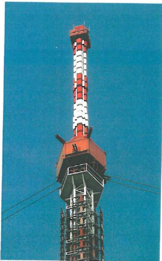
Obr. 1 – Výměna laminátového tubusu pomocí vrtulníku (vlevo), nový ocelový nástavec s kapalinovým tlumičem kmitů ve vrcholu (vpravo).
