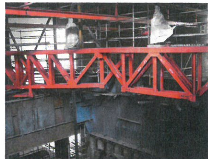
Obr. 3 – PPK po spuštění roštu s kotlem
