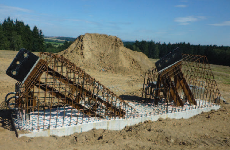
▲ Kotevní rošty před zabetonováním
