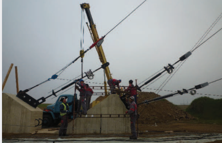
▲ Montáž kotevních lan
