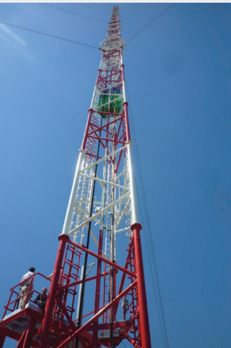
▼ Stožár Křešín po dokončení
