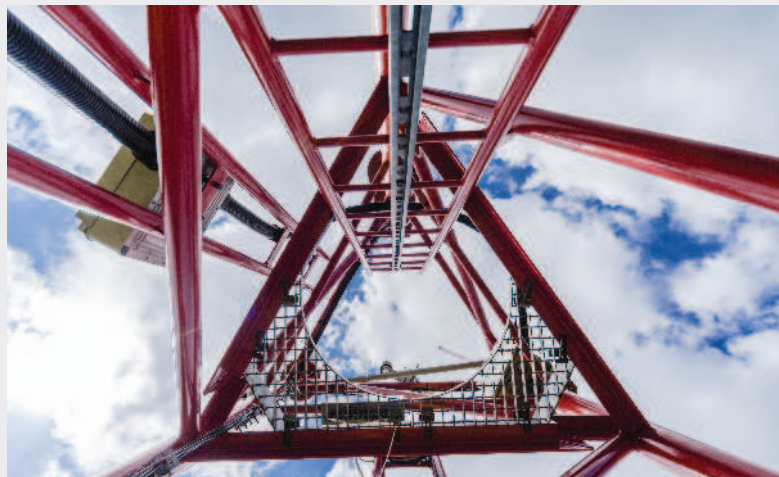
▲ Těleso stožáru tvořené příhradovými ocelovými celosvařovanými díly
