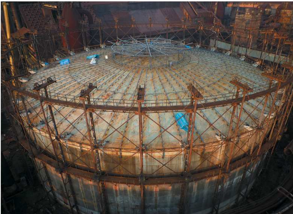
Vnější pohled na zdvih zvonu plynojemů s novým tamburem Outside view to heavy lifting of the crown with new card cylinder
