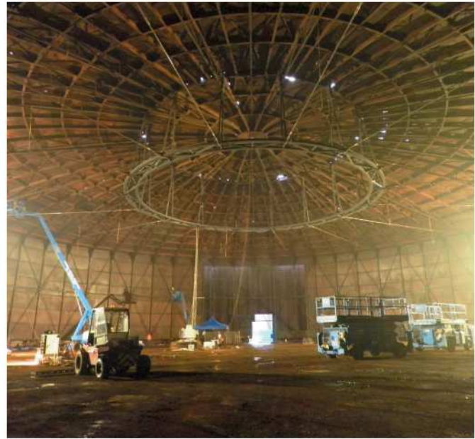
Montáž a předpínání vzpínadla Erection and prestressing of the beam string structure
