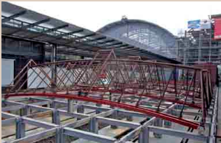
Obr. 25 Uložení světlíků z pole 19 A-B na montážní stůl, kde byly světlíky opraveny, svrtány s novými světlíkovými nosníky a natřeny
