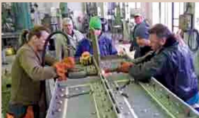
Obr. 17 Nýtování sloupu 1B v dílně
