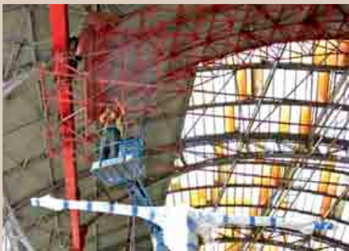
Obr. 23 Posuvná montážní lávka nad IV. nástupištěm
