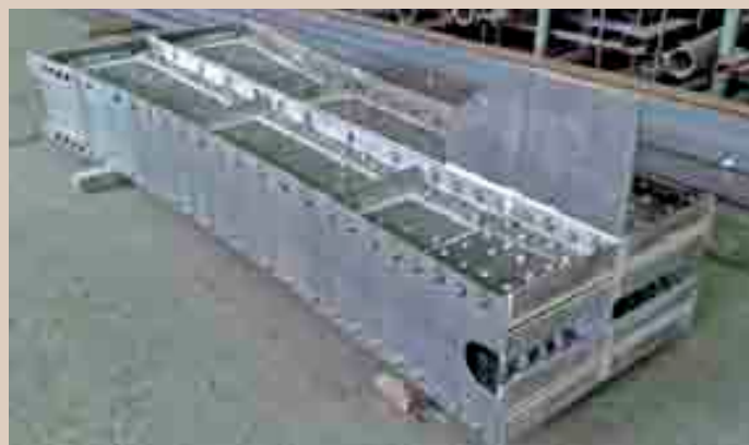
Obr. 18 Sloup 1B po sestavení v dílně
