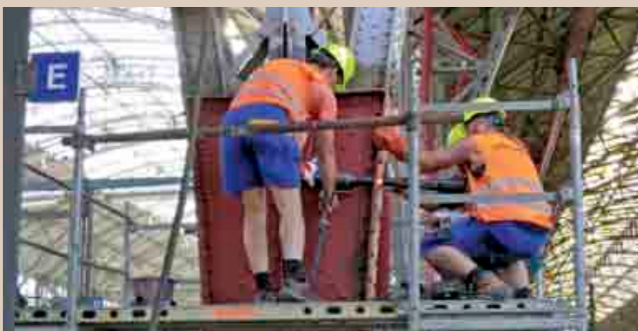
Obr. 19 Nýtování sloupu 1B na III. nástupišti na montáži
