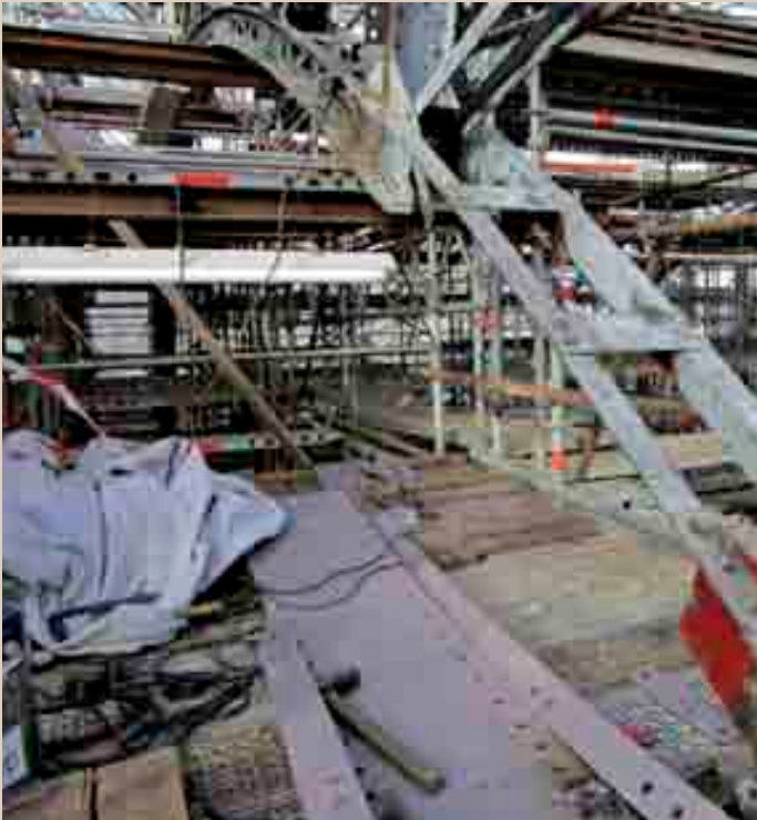
Obr. 7 Spodní pas příčné vazby během opravy
