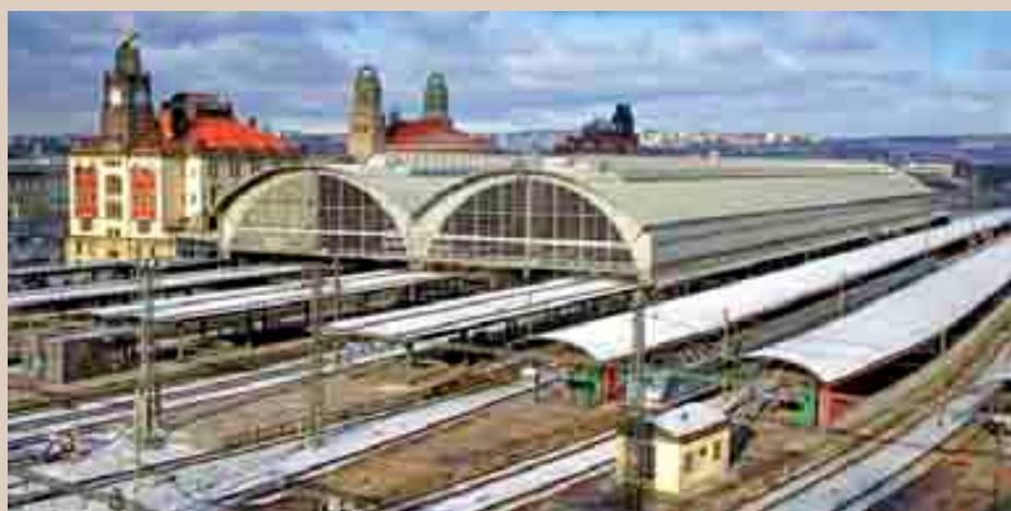
Obr. 1 Pohled na jižní čelní fasádu po dokončení 6. etapy obnovy
