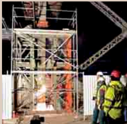
Obr. 14 Demontáž sloupu 1B na III. nástupišti podepřeného provizorní podporou
