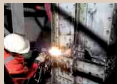
Obr. 15 a 16 Demontáž sloupu 1B na III. nástupišti podepřeného provizorní podporou
