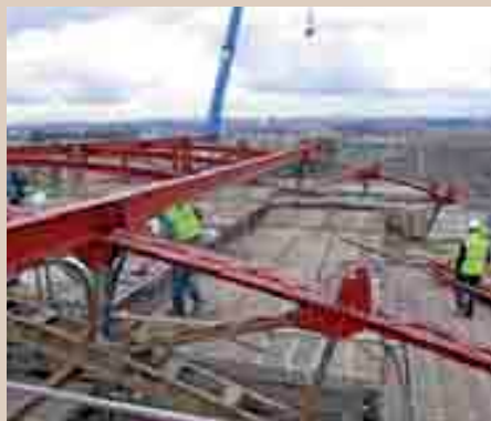
Obr. 27 Montáž nových horních pasů vazníků, vaznic a propojek vaznic. Vazba 20 nad III. nástupištěm
