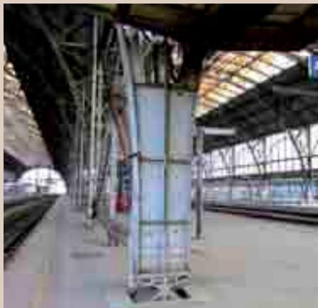
Obr. 13 Sloup 1B na III. nástupišti. Plnostěnná část je vyměněna
