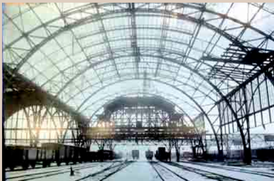
Obr. 2 Montáž ocelové konstrukce nástupištní haly v letech 1905–1906
