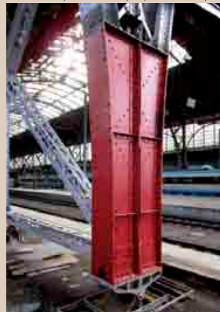
⇩ Obr. 20 Sloup 1B na III. nástupišti po dokončení oprav
