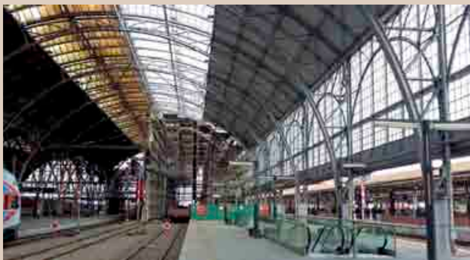
Obr. 4 Prostorové lešení pro 3. etapu obnovy
