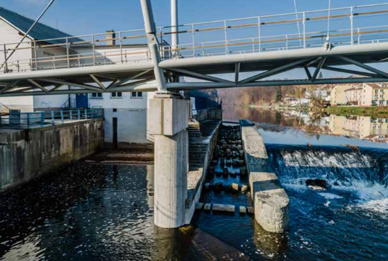
▲ Obr. 5 Uložení visuté lávky na pilíři P1 a rybí přechod (foto: Tomáš Malý)
