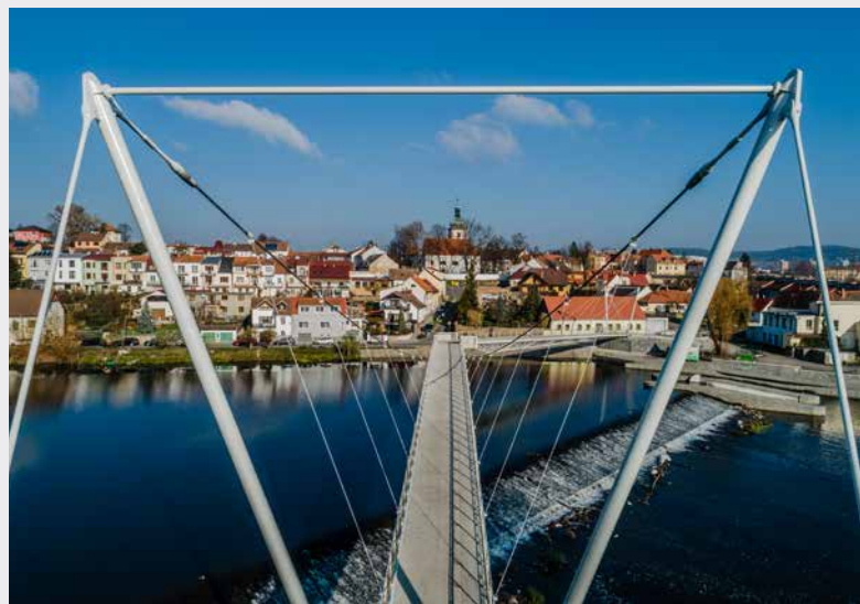
▲ Obr. 8 Geometrie kotvení lan a táhel ve vrcholu pylonu (foto: Tomáš Malý)
