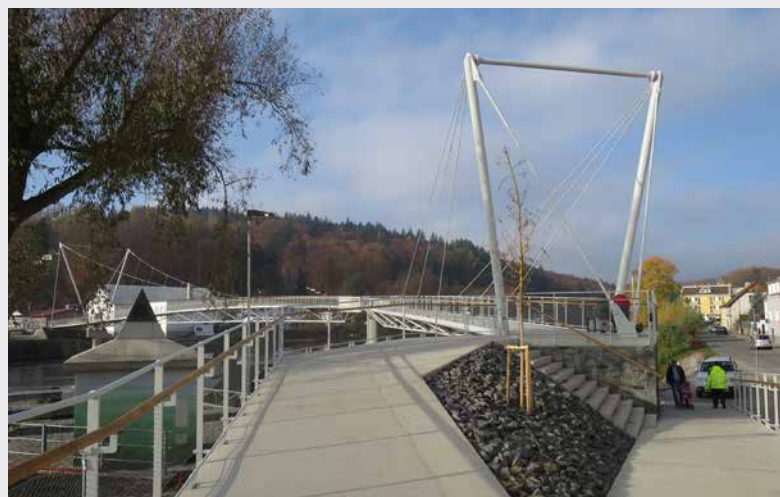
▲ Obr. 3 Zavěšená lávka, směr kultovní vrch Hradiště. V předpolí lávky je patrný systém kotvení zadních táhel (foto: Tomáš Malý).
