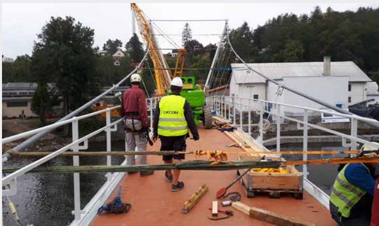
▲ Obr. 15 Montáž závěsů, lana v horizontální poloze zajištěna stripy
