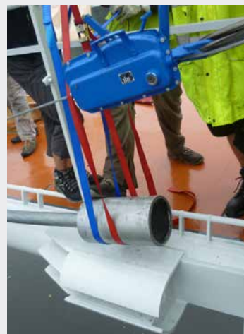
▼ Obr. 12 Lávka visutá, montáž válcové koncovky do boční výtzuhy na horním pasu tělesa lávky
