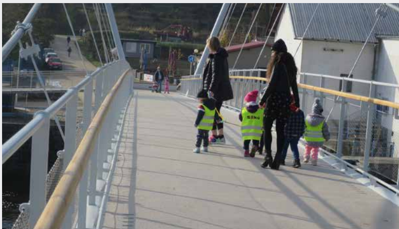
▲ Obr. 17 Mostovka, zábradlí, madlo
