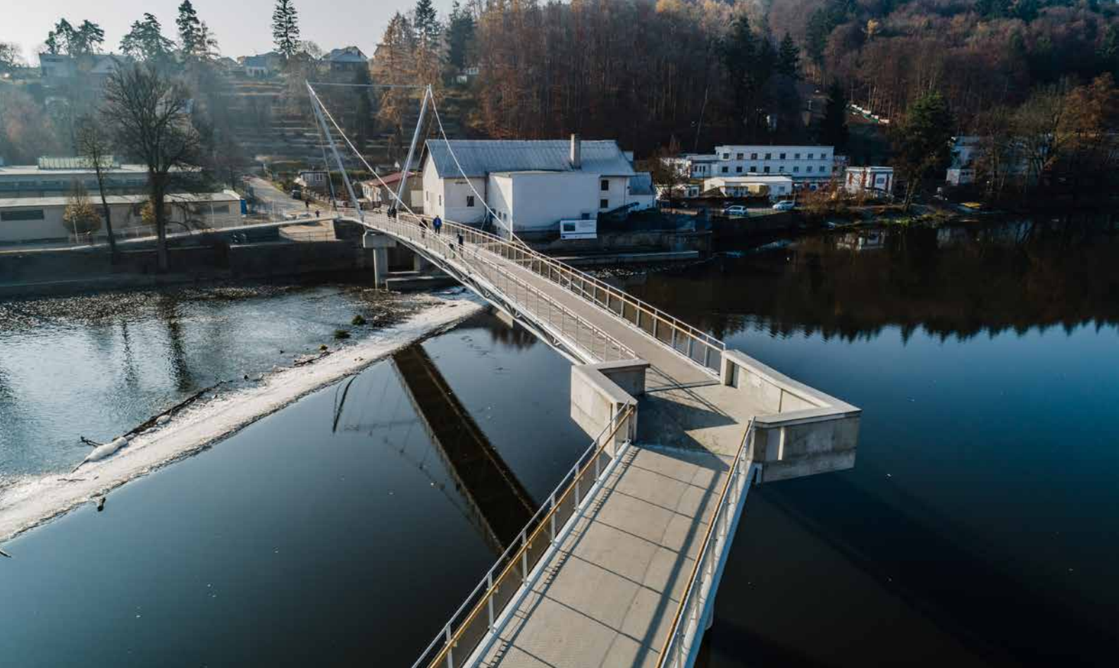
▲ Obr. 10 Plošina na pilíři P2 (foto: Tomáš Malý)
