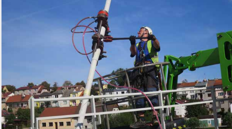
▲ Obr. 16 Napínání táhel hydraulickým zařízením
