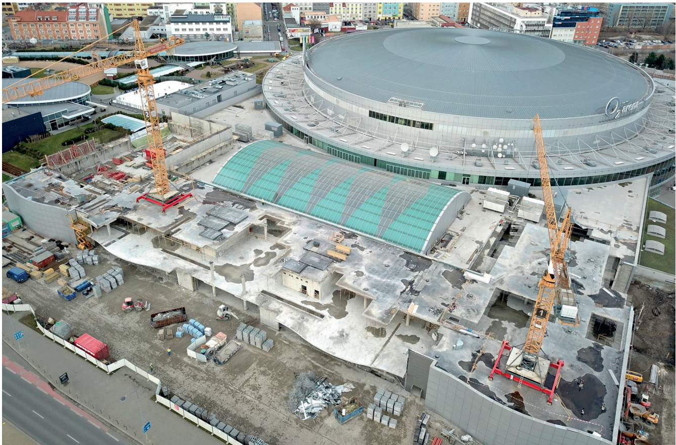
Pohled na staveniště v době dokončování bouracích prací (Zdroj: norman rourke pryme)
