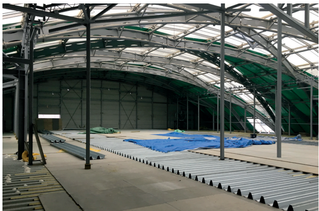
Vznikající sály E (montáž lehké podlahy, realizace nosné konstrukce příček)
