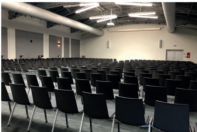
Sál E (nové sádkartonové příčky, zastíněný světlík nad sálem, akustické textilní obklady na stěnách)
