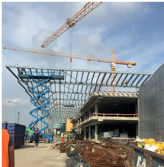
Montáž ocelové konstrukce markýzy
