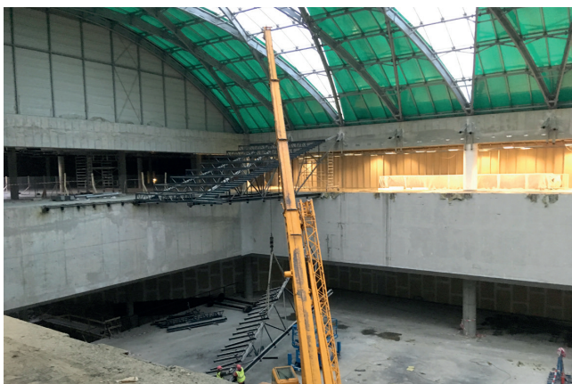
Demontáž posledního pole ocelové konstrukce původního ocelového „náměstí“
