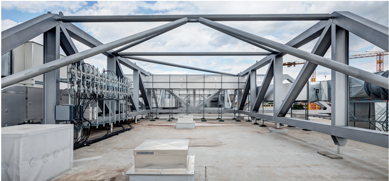
Pohled na ocelovou superkonstrukci nad sálem B
