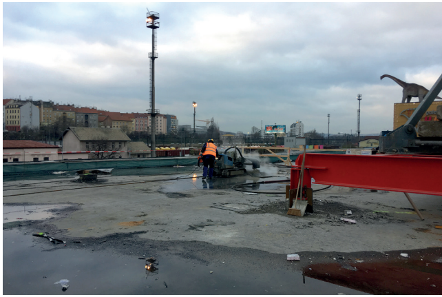
Zařízení pro hydrodemoliční práce
