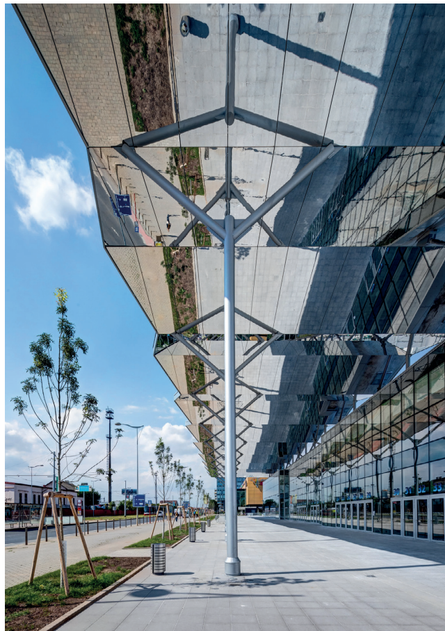
Pohled pod markýzu nad hlavním vstupem
