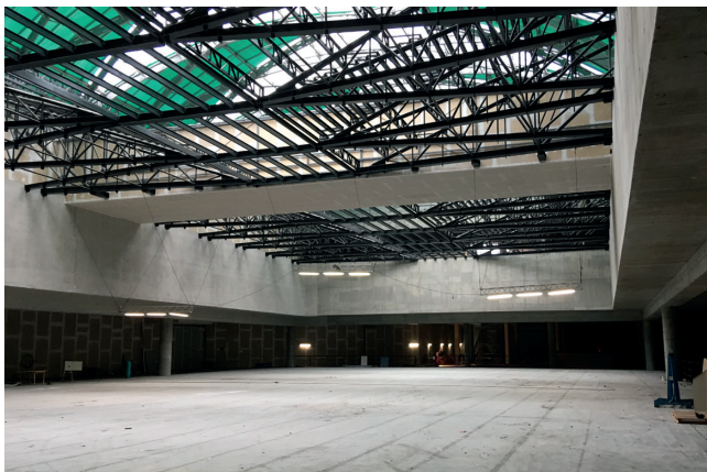
Původní konstrukce „náměstí“ nad sálem A
