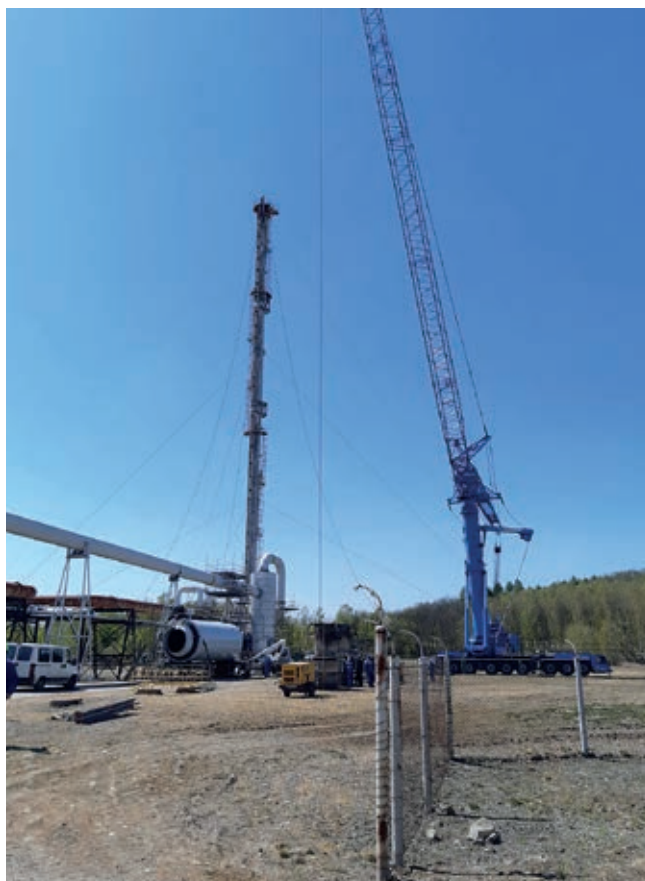
Obr. 8 – Povolená lana horní kotevní úrovně, provizorní kotvy
