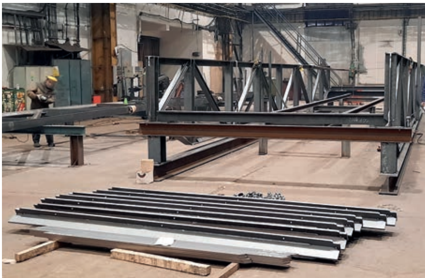
Práce na výrobě ocelové konstrukce
