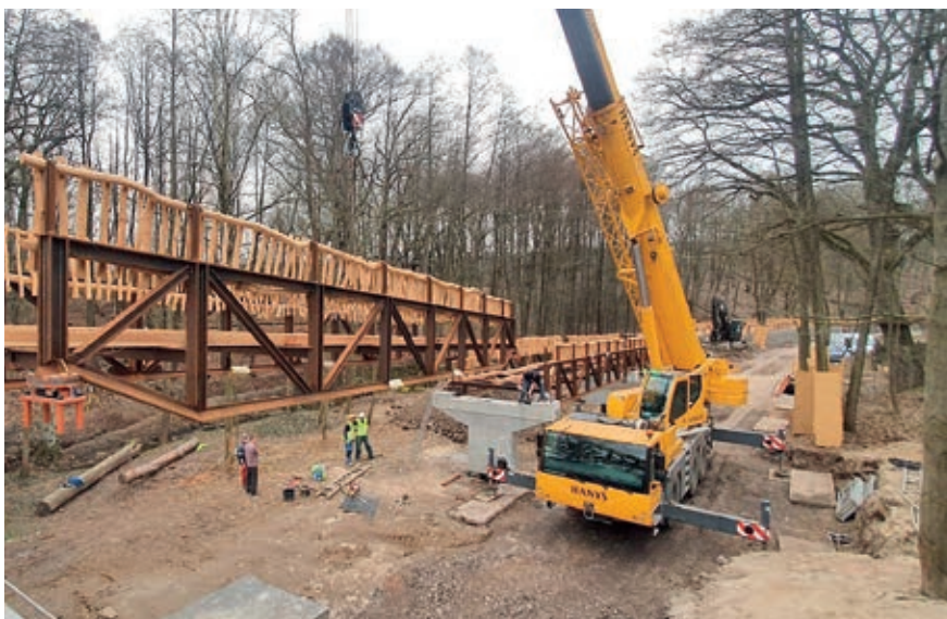
Nutností bylo nasazení výkonných jeřábů
