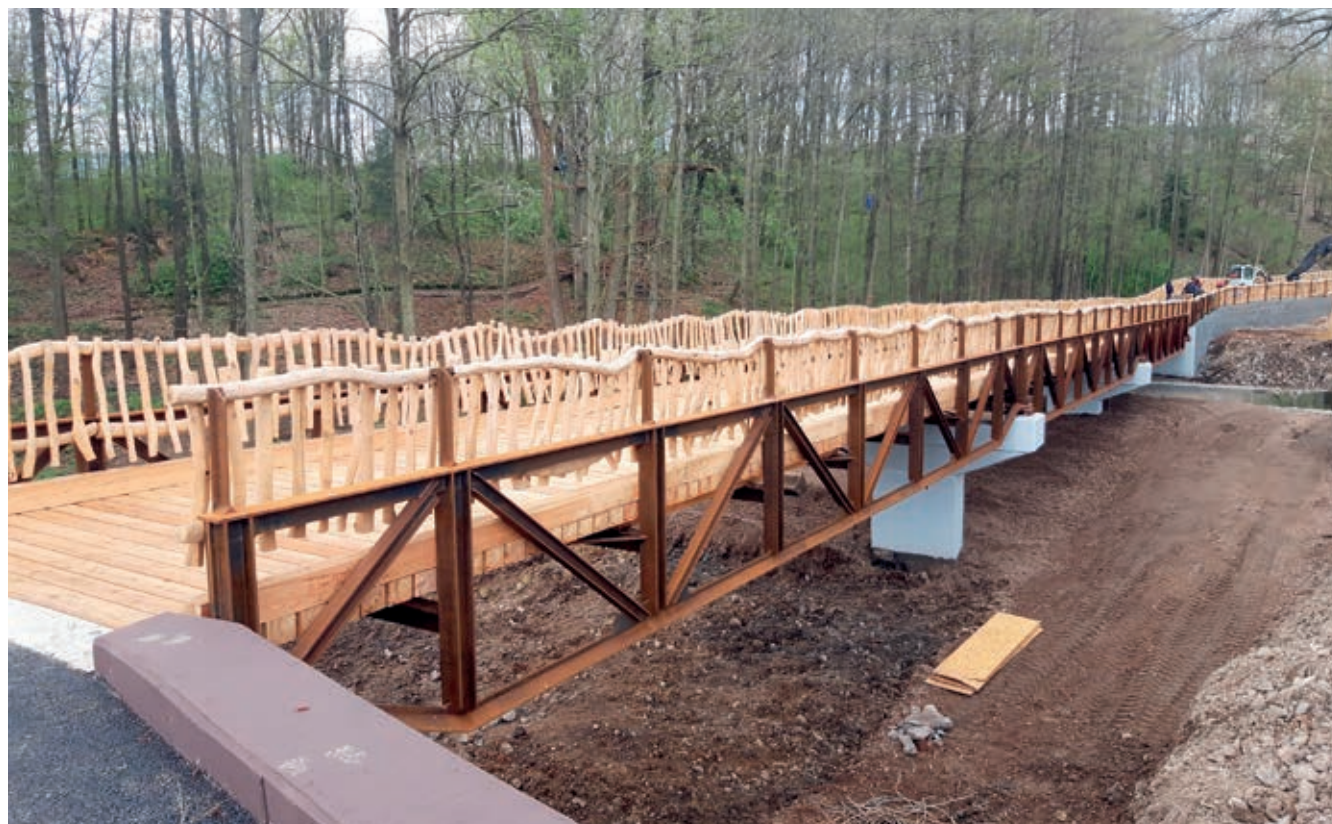
Pohled na novou lávku nad výběhem hrochů
