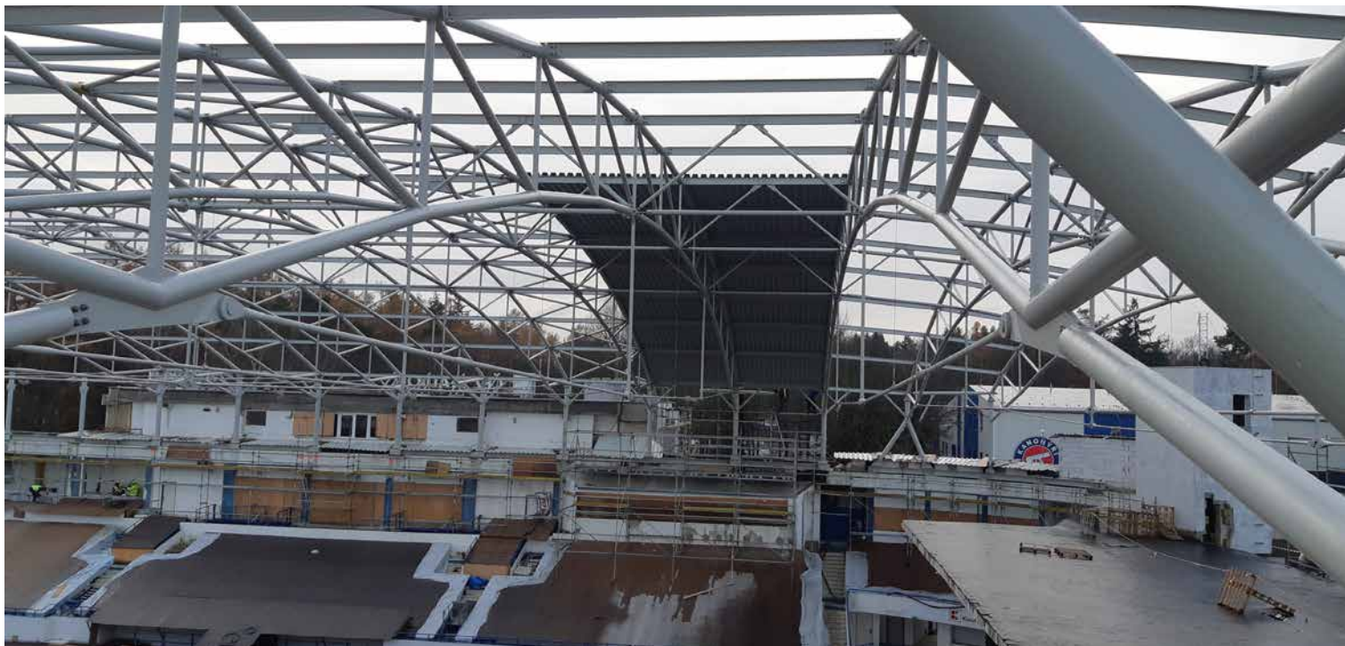
▲ Obr. 10 Ocelová konstrukce zastřešení zimního stadionu
