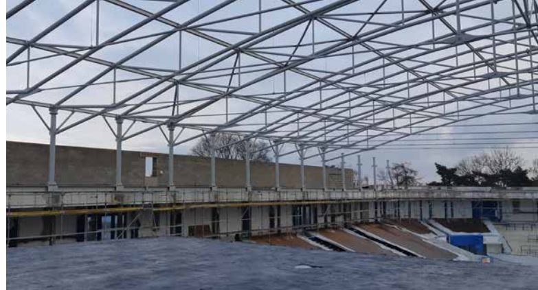
▲ Obr. 9 Uložení vazníků na sloupy kotvené do zesilujícího průvzlaku
