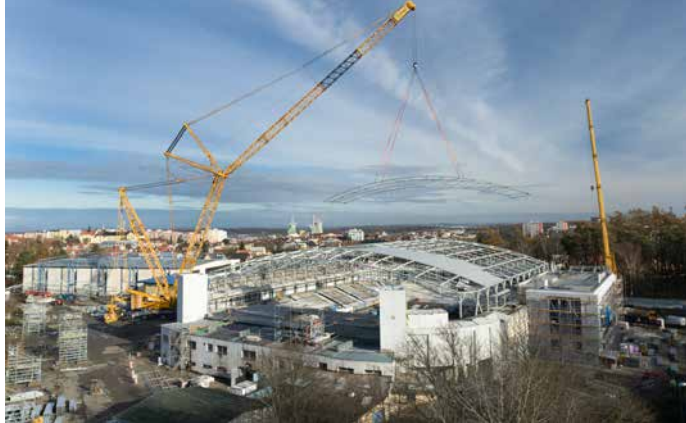
▲ Obr. 8 Montáž ocelové konstrukce střechy a opláštění
