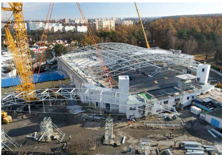
▲ Obr. 13 Závěr montáže vazníků; v popředí zdvih montážního dílu ocelové konstrukce haly
