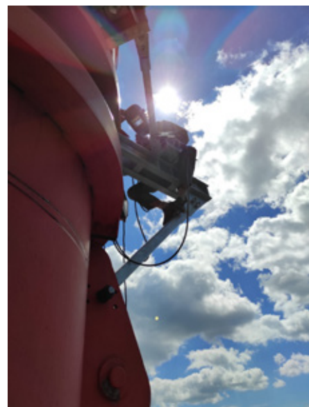
▲ Obr. 8, 9 Montáž výložníků a kladek pro zdvihové lano (foto: Stanislav Pelikán, Jindřich Syrovátka)
