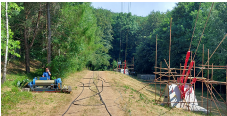
▲ Obr. 10 Odtahový vrátek, kotevní bloky lan (foto: Jindřich Syrovátka)
