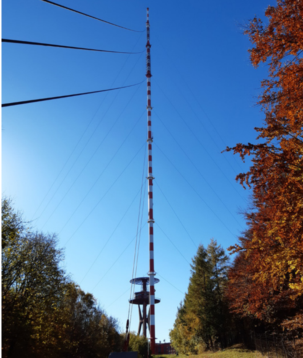
▲ Obr. 1 Kotvený stožár Dubník (foto: Jiří Lahodný)
