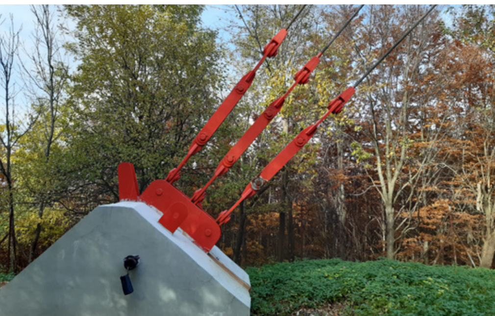
▲ Obr. 5 Původní zakončení lan u kotevního bloku (foto: Jiří Lahodný)
