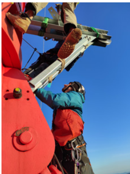
▲ Obr. 8, 9 Montáž výložníků a kladek pro zdvihové lano (foto: Stanislav Pelikán, Jindřich Syrovátka)
