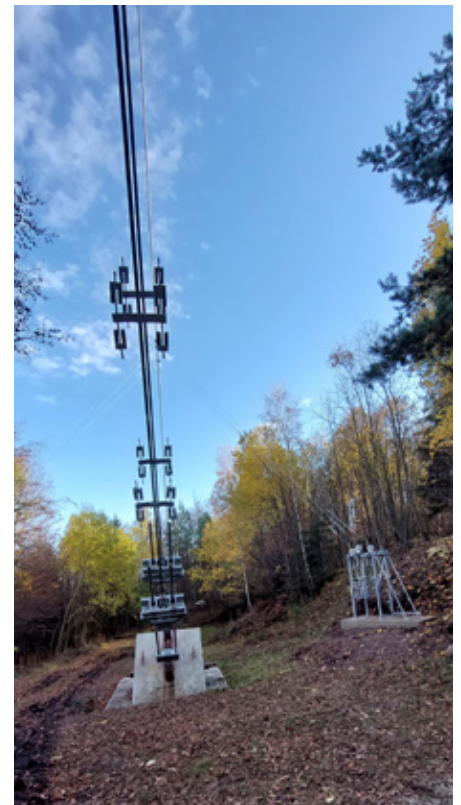
▲ Obr. 16 Vyskofrekvenční pohlcovače na lanech a nízkofrekvenční tlumiče na pomocné konstrukci na zemi (foto: Jindřich Syrovátka)
