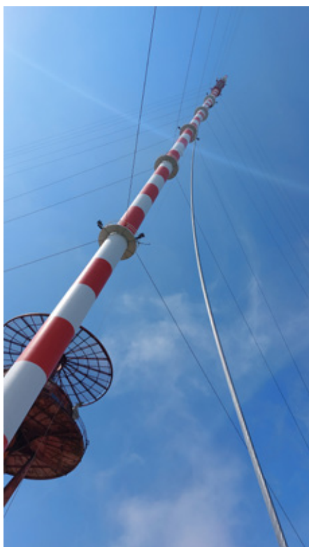
▲ Obr. 11 Zdvih nového lana (foto: Jindřich Syrovátka)
