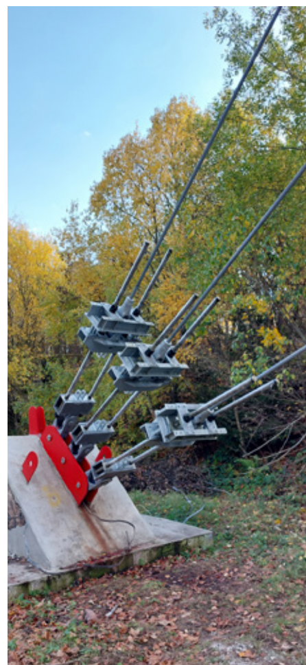
▲ Obr. 6 Nové zakončení lan s montážním příčníkem pro rektifikaci (foto: Jindřich Syrovátka)
