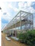
Pohled na hlavní ocelovou konstrukci.
